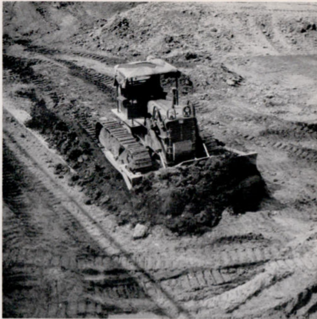
In einer Schicht von 10 Stunden verschiebt jede TD 14 1 000 m 3 Material auf 30 bis 50 m
