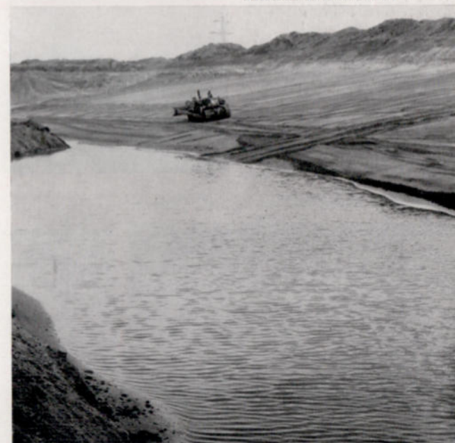
An einem Ufer des zukünftigen Neusser Schwimmbades plant bereits eine INTERNATIONAL TD 14 den Strand ein.
