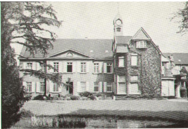
Ein Blick vom herrlichen Park auf das Hauptgebäude.
