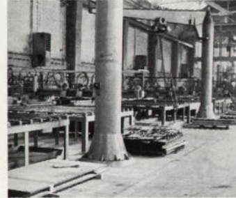
Auf dem 1. und 2. Bild sehen Sie 3 unserer Brennschneidmaschinen in der Zurichterlei. Jede Brennschneidmaschine ist mit 4 Brennern ausgerüstet.
