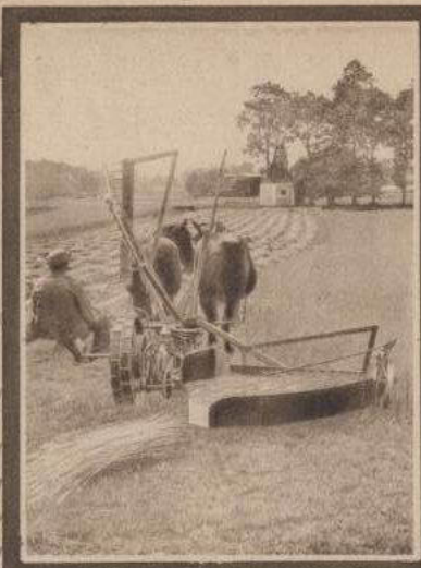
DEERING-Getreidemäher mit beiderseitig verzinkter Stahlplattform und im Ölbad laufende Getriebe. 5 Fuss (1,52 m), zwispännig; 4 Fuss (1,23 m), ein- oder zwispännig.
