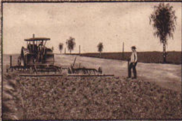
Die IHACE Zugmaschine zieht 8 Kultivatoren
